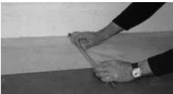
Coloque la hoja a cortar sobre la hoja de al lado asegurándose de que está correctamente alineada (los bordes deben estar paralelos). Con un trazador grande ajustado al desplazamiento de la chapa, marque el perfil de la pared en el pavimento.
