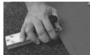
5 cm contra las paredes durante la instalación. Los extremos no se cortan hasta después del encolado.
